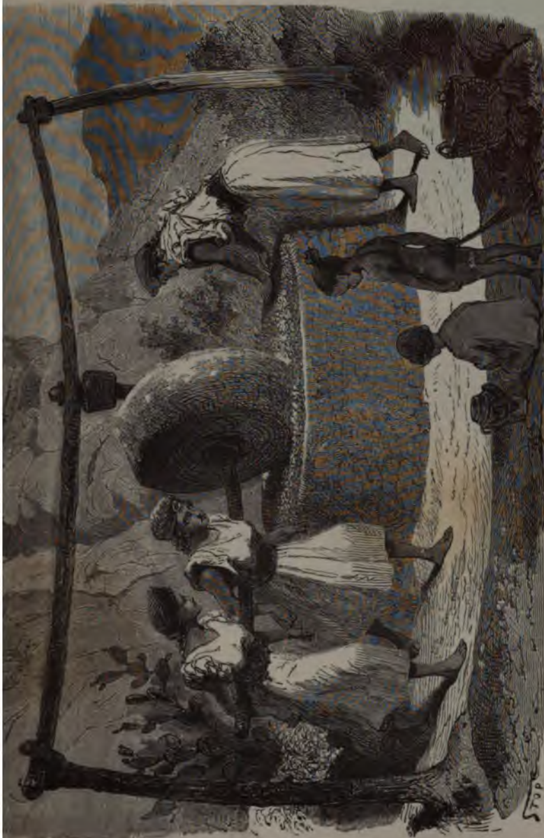
Fig. 78. Moule à broyer les olives dans la Kabylie.
