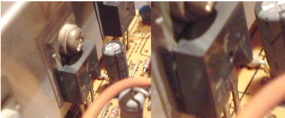
Figura 75.5. Integrato di regolazione bruciato; lo si capisce dalla rottura che appare nella parte inferiore.
